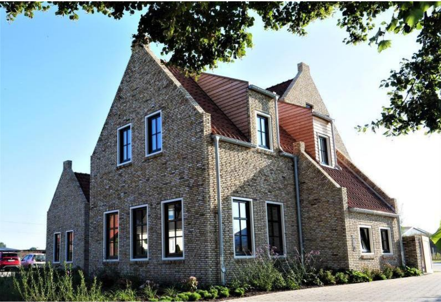
Der neue Firmensitz „Hinter den Höfen 6“: Das Gebäude wurde im westfriesisch-ameländischen Stil errichtet.
